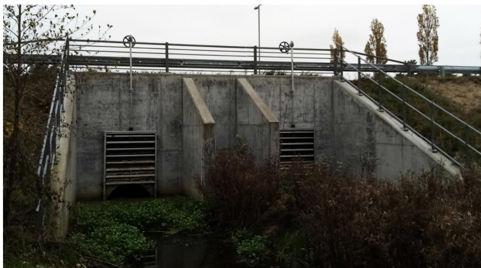
Figur 5-4 Underføring af Karlstrup Møllebæk med stibord udfør de to rørunderøringer
