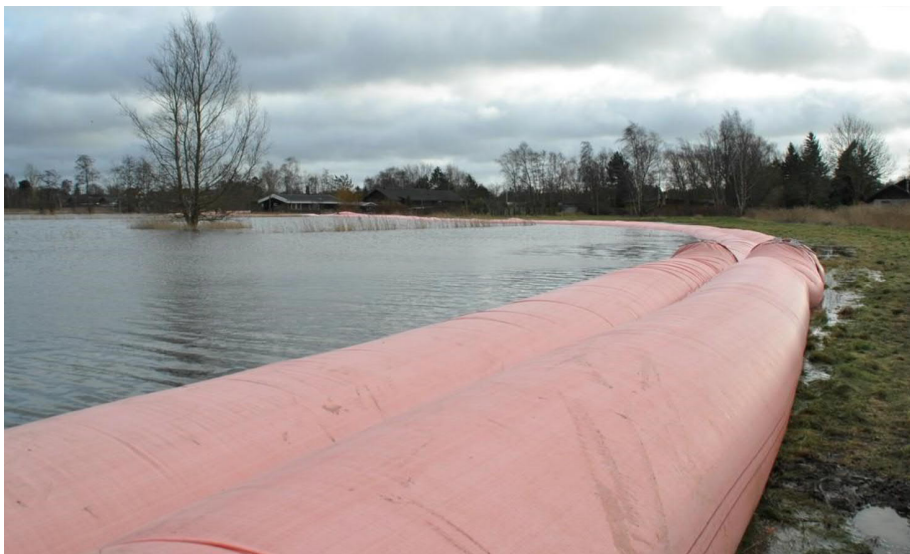
Figur 5-14 Eksempel på højvandssikring med Water tube fra NoFloods.dk
