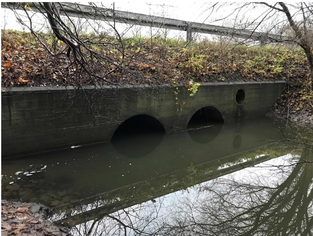
Figur 3-1 Underføring af Karlstrup Mosebæk, set fra øst
