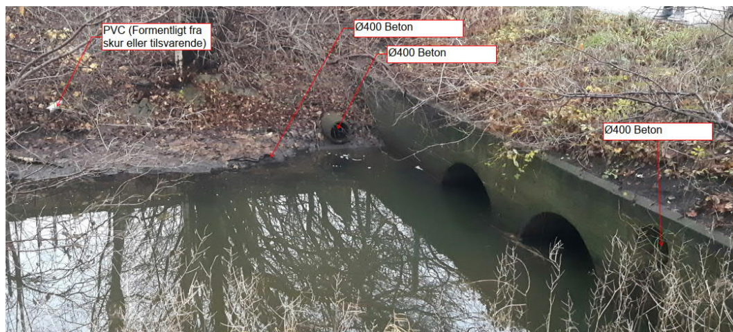
Figur 5-6 Fire udløb er lokaliseret nedstrøms Strandvejen.
