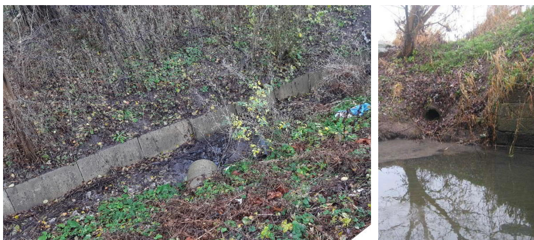
Figur 5-22 Udløb i grøft nordøst for bro (tv), samt udløb sydøst for bro over Skensved Å (th)
